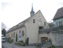
Lauffen am Neckar Ehemalige Klosterkirche (heute Stadtmuseum) - 2. Hälfte 13. Jh., Neubau 1924 (a) Gefügekundliche Untersuchung an der Außenwand
