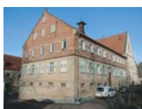
Sachsenheim - Rechentshofen sog. Verwalterbau im ehem. Zisterzienserinnenkloster - 1866 (i) und 1882 (d, i) Bauhistorische und restauratorische Untersuchungen Gefügekundliche Forschung, Dendrochronologische Datierung, Bauphasenpläne
