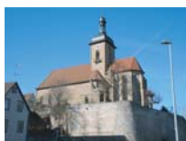
Lauffen am Neckar Evangelische Regiswindiskirche - 1227 (i), Umbauten 1564-1567 (i) 3d-Bauaufnahme des Innenraums
