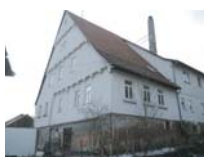
Winnenden - Hertmannsweiler - Degenhof Ehemaliges Maiereigebäudes des württembergischen Schafhofs - 1557 (d) Bauhistorische Untersuchung 3d-Bauaufnahme, Dendrochronologische Datierung, Bauphasenpläne
