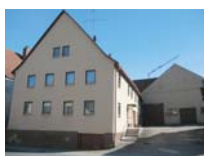
Igersheim - Harthausen Winkelgehöft - 18. Jahrhundert, Keller 1790er Jahre (d) Bestandsdokumentation zu drei Kellerräumen 3d-Bauaufnahme, Dendrochronologische Datierung
